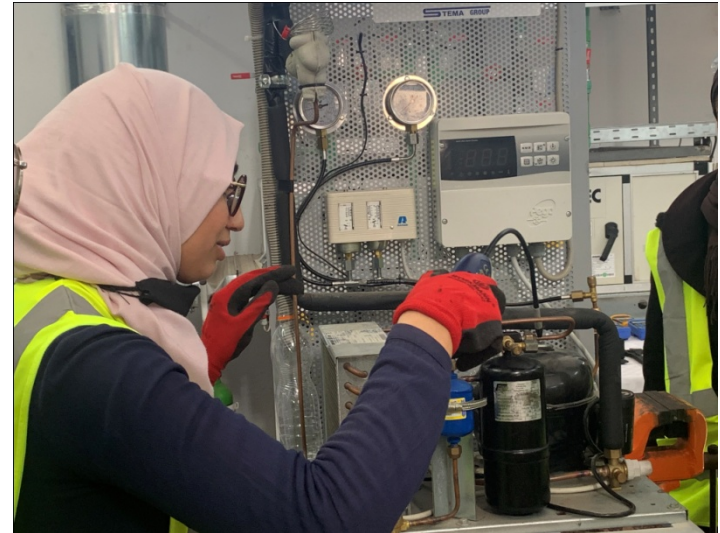
Détection électronique des fuites
