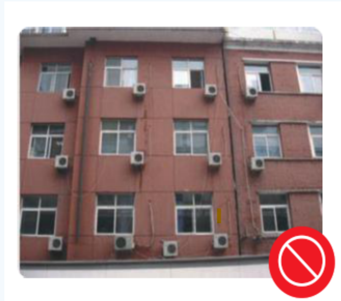
Photo 14 : Bâtiment avec de nombreuses unités extérieures.
